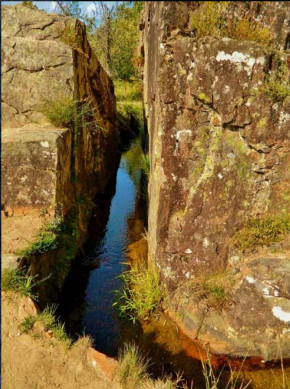
abbazia cistercense di Obazine: canale di adduzione scavato nella roccia
